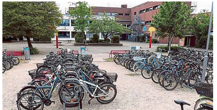
Würde das Schulzentrum (im Bild die Marion-Dönhoff-Realschule) saniert, gingen Jahre ins Land. Foto: Maria Machnik
